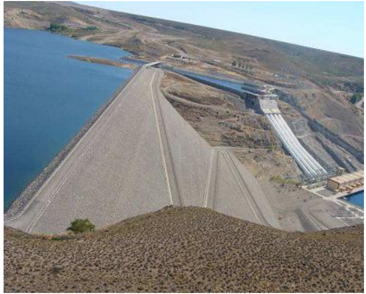
Figura 2.- Presa de Alicurá
