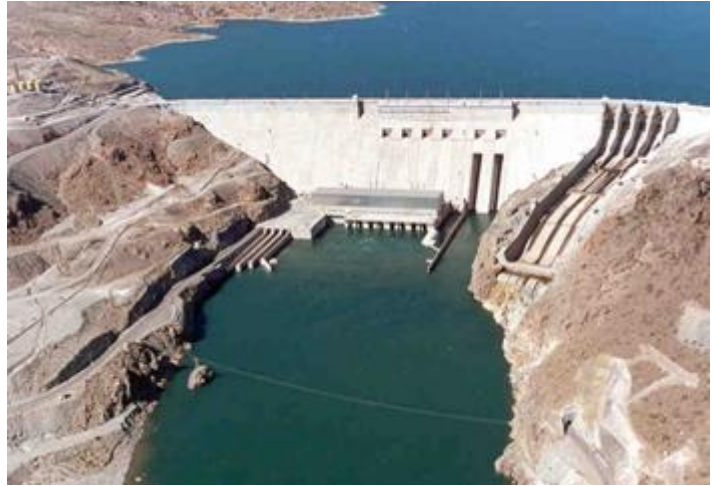
Figura 6.- Presa de Piedra del Aguila
